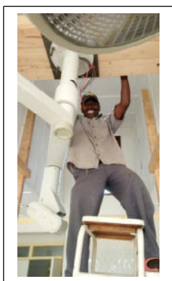
Christopher bei der Montage der Unterkonstruktion der OP-Lampen
